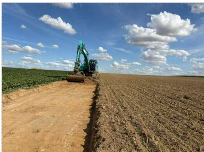
Décapage de la terre pour la création des chemins d'accès
