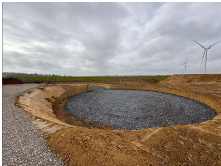
Réalisation du matelas de travail, pour le renforcement du sous-sol par inclusions rigides
