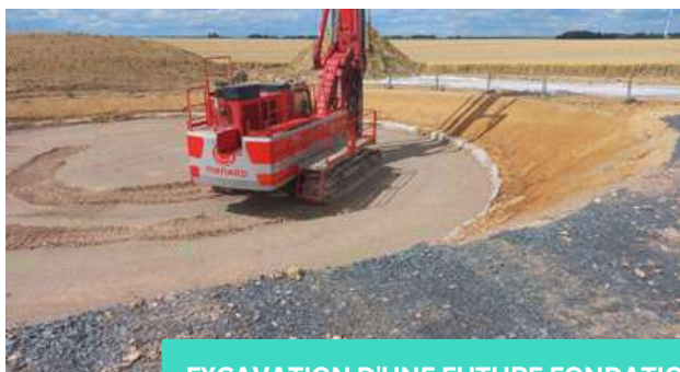
EXCAVATION D'UNE FUTURE FONDATION
