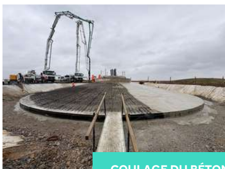
COULAGE DU BÉTON
