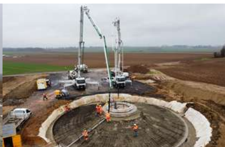
APRÈS COULAGE DU BÉTON DE PROPRIÉTÉ : MONTAGE DE LA CAGE D'ANCRAGE ET FERRAILLAGE
